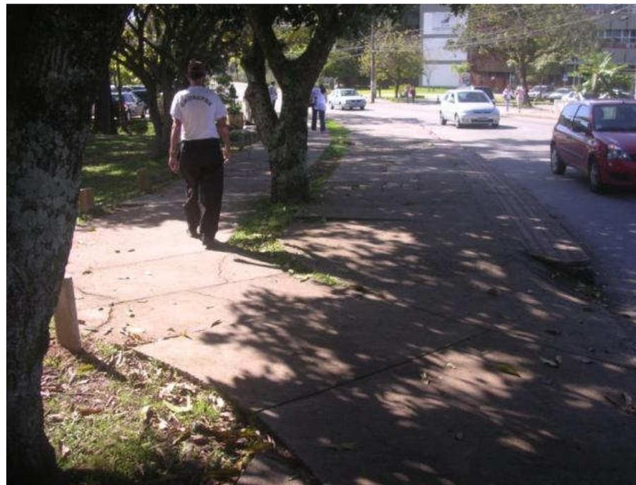
Pavimentação inadequada, falta de conservação e descontinuidade dos passeios
