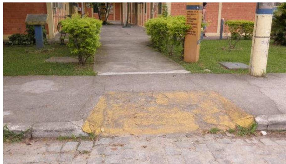
Rampas com inclinações inadequadas e calçadas sem manutenção
