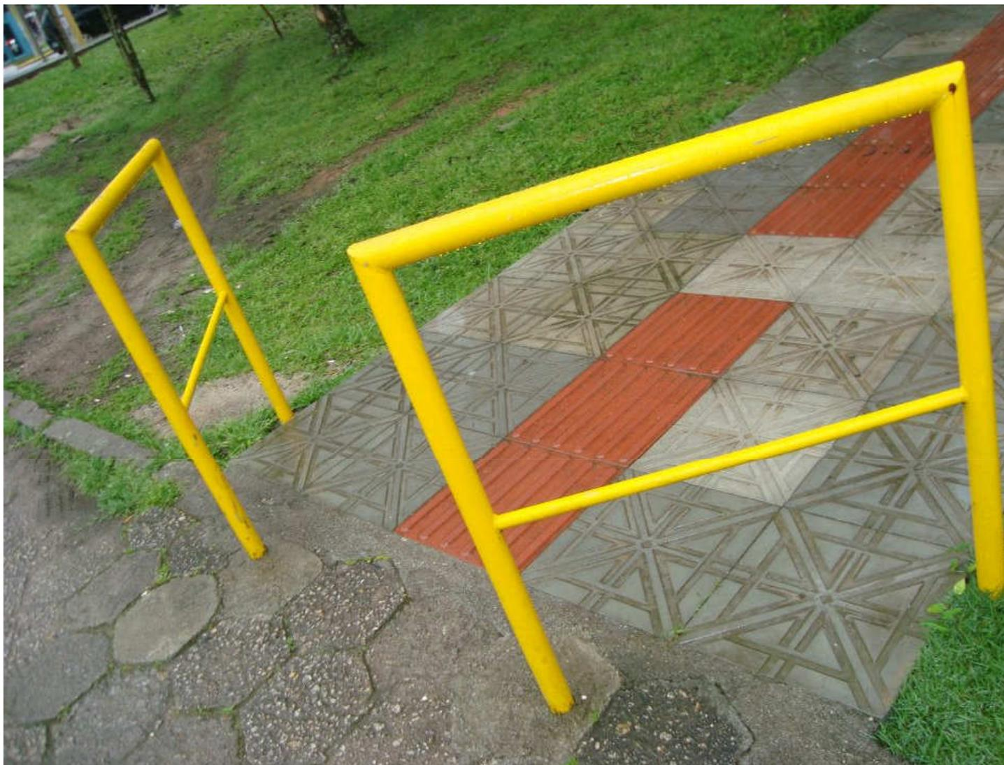
Piso tátil interrompido e passagem obstruída
