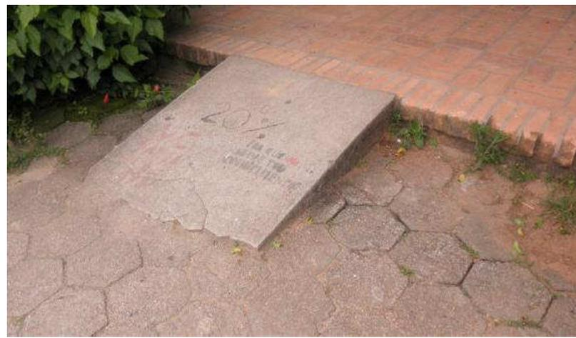
Escadarias com degraus incorretos, rampa com inclinação fora da norma
