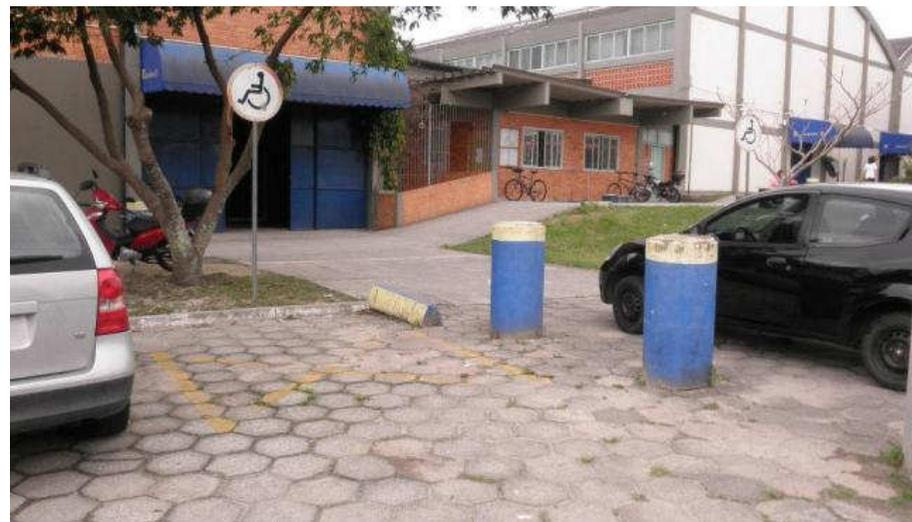
Calçadas de pavimentação irregular e sem piso tátil; vaga de estacionamento para cadeirante fora da norma
